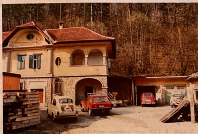
Stavba KŽK pred obnovitvijo
